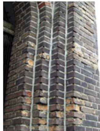
Toren aangetast metselwerk, vorstschade ontstaan door inwatering en het impregneren van het metselwerk
