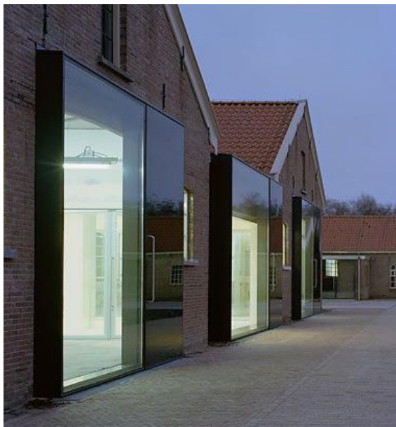
Het met respect voor de bestaande opstal openen van de bestaande gevels
