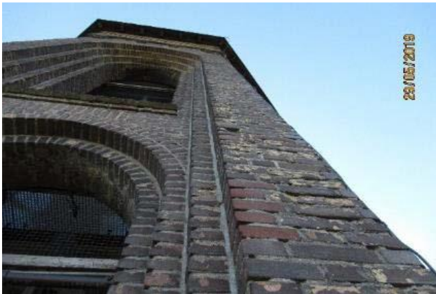
Toren aangetast metselwerk, vorstschade ontstaan door inwatering en het impregneren van het metselwerk
